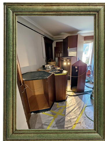
Unser Alpenzimmer in der Entstehungsphase (März 2025).
